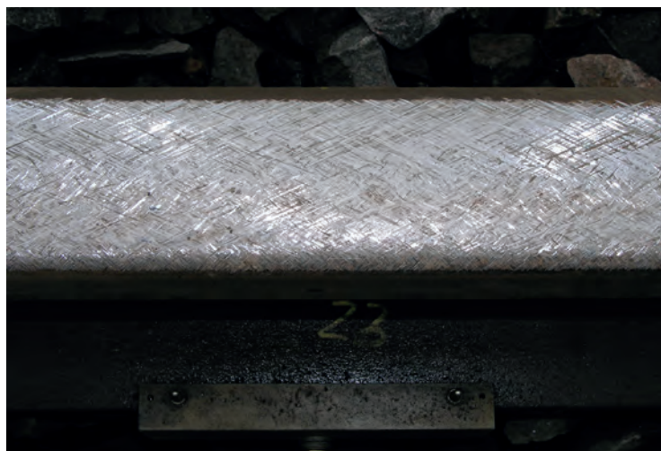
Рис. 5. Рисунок шлифовки без скошенных кромок после обработки рельса HSG-city
